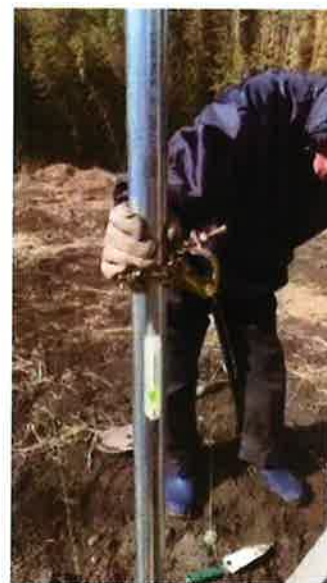
ZOOM講習会で、パイプの垂直を簡単に出せる糸に重りをつけてたらす方法紹介（2/9）
