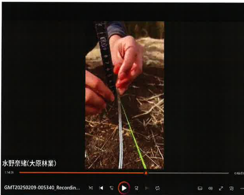
パイプ棚を立てる前に一番大事な水平出しを、水とホースで行う研介 (2/9)
