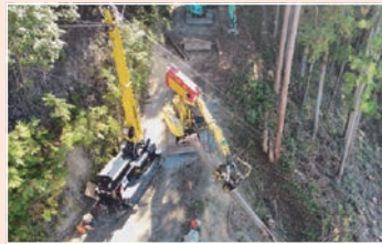
▲主伐現場で稼働する 先進林業機械
