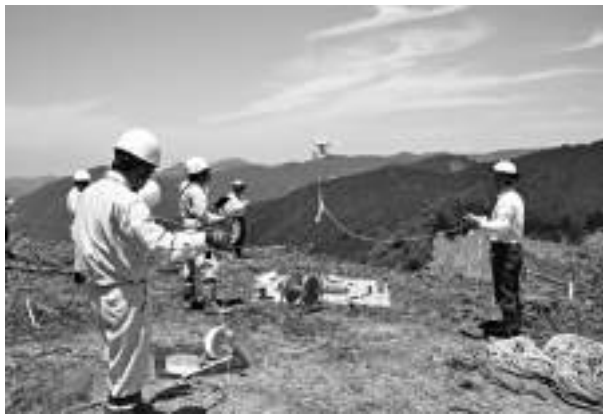
図-4 UAVによる索張り実証実験
