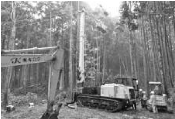
タワーヤードの設置
