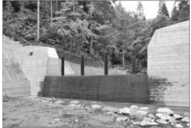
写真-4 完成した流木捕捉式治山ダム
