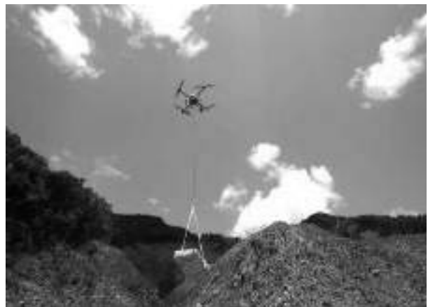
写真6 大型UAVによる資材運搬
