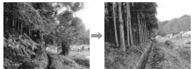
緩衝帯整備 施行前
