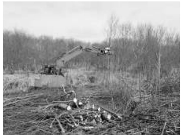
写真-2 河道内樹木の伐採・除去
