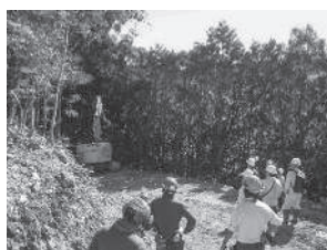
森林作業道作設状況
