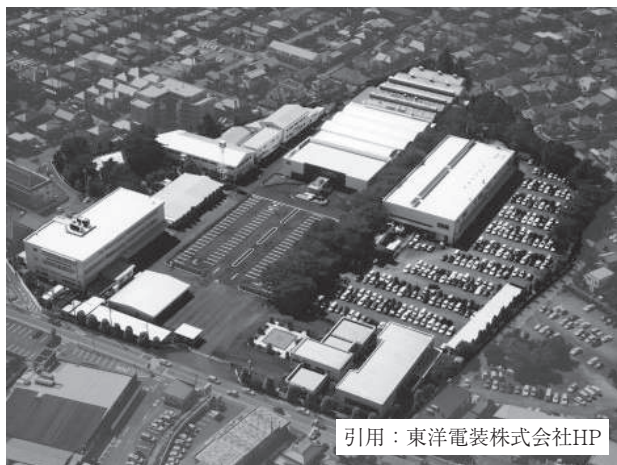
図2 東洋電装テクニカルセンター（埼玉県鶴ヶ島市）
