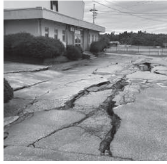
写真6 被災した地元小学校
