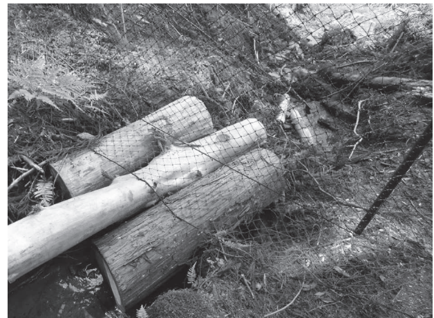
写真2 沢跨ぎ方法の改善（丸太を使った排水）
