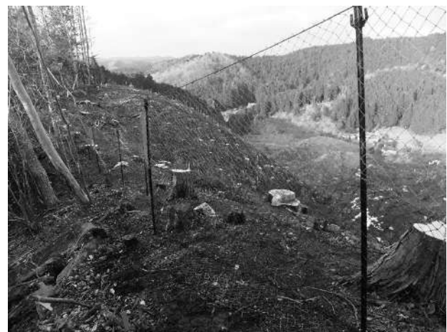
写真4 新仕様設置の様子
