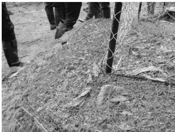
写真3 L型防護柵（森林整備センター）
