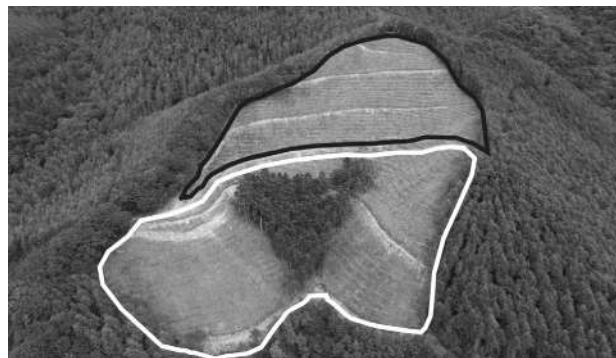
写真－２ ブロックディフェンス設置
