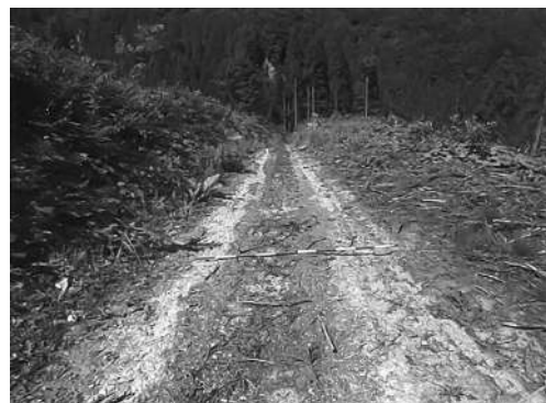
既設造林作業路
