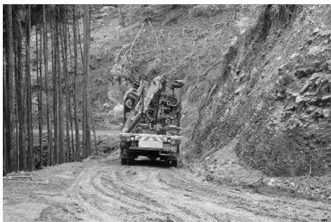
地形・地質を活かしたトラック作業道
