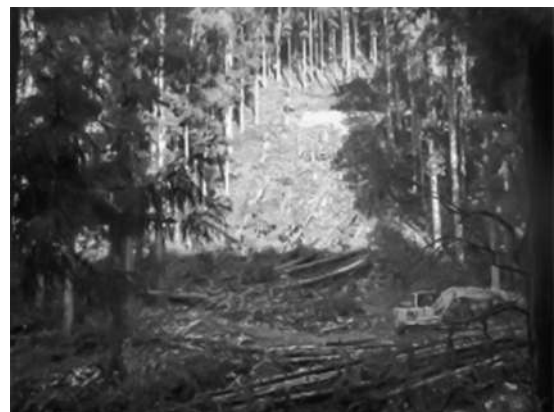
伐採作業中の様子
