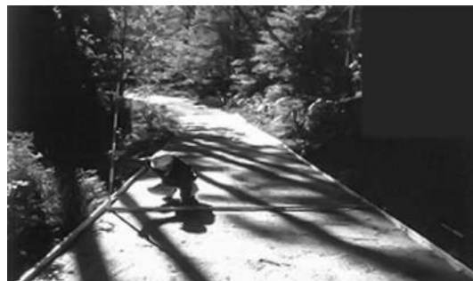
コンクリート路面工を施工
