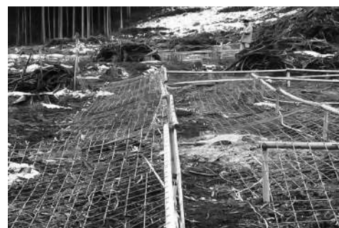
図4 ワイヤーメッシュの設置状況
