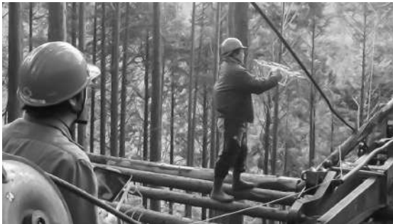
ドローンによる予備線の送り出し
