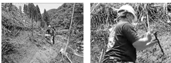
写真-4 L字型スカートネットの施工状況 (L字の踵部分にアンカーを打ち込みネットを密着)
