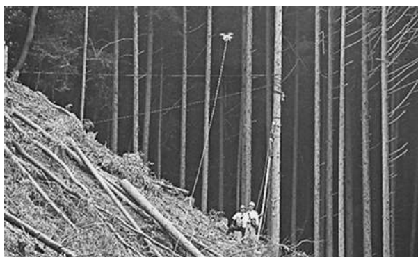
写真1 先柱へ向かうドローン
